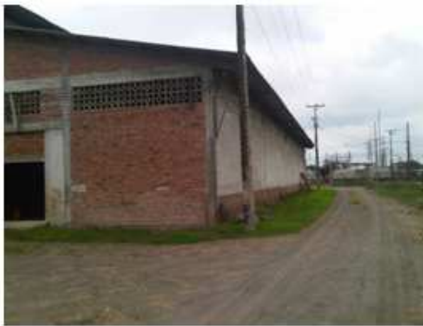
Imagen exterior de la planta
