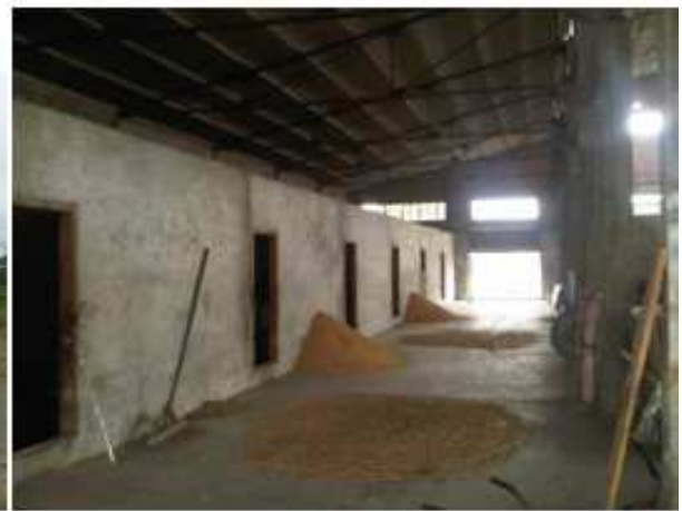
Imagen interior de la planta
