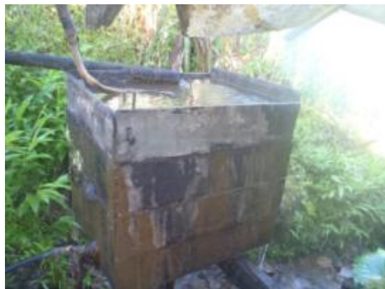
Figura 17: Tanque con agua a baja temperatura que contiene la serpentina de cobre
